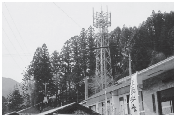
図1 地域WiMAX基地局（愛媛県新居浜市別子山地区）
